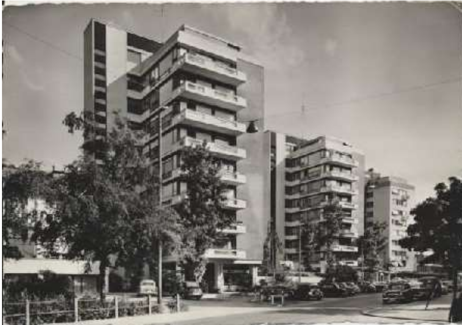
Ca. 1965 (Postkarte). Die damals noch 3 Lämmlisbrunn-Hochhäuser (v.l.n.r.) Nrn. 50, 44 u. 34.
