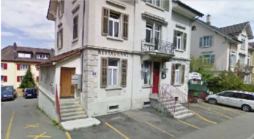
Ehem. Rest. Eintracht, Affolternstr. 98, 8050 Zürich (2009)
